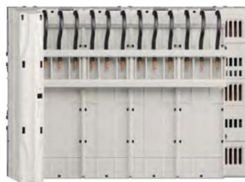
**Konfiguration 2** Einfacher Aufbau für Abgänge mit Motorschutzschaltern
